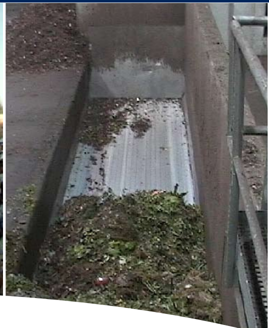
Storage & transport bunker for green waste Lager- und Transportbunker für Grünabfälle
